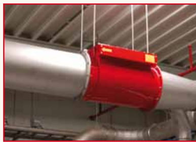
Explosiebeveiliging - terugslagklep
